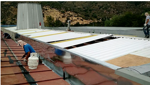
Trabajos con membrana asfáltica con sellado de termo fusión. Cambio de planchas traslucidas
