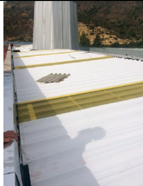
Cambio de planchas en Galpón.
