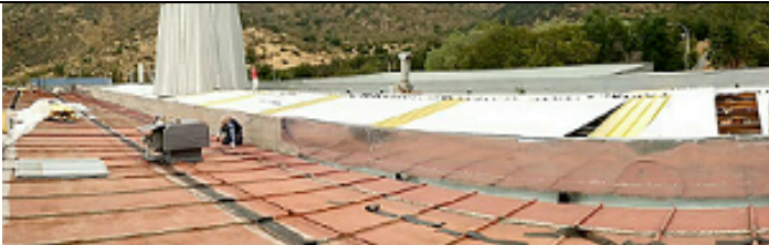
Vista hacia el poniente de techumbre de Planta Piloto.
