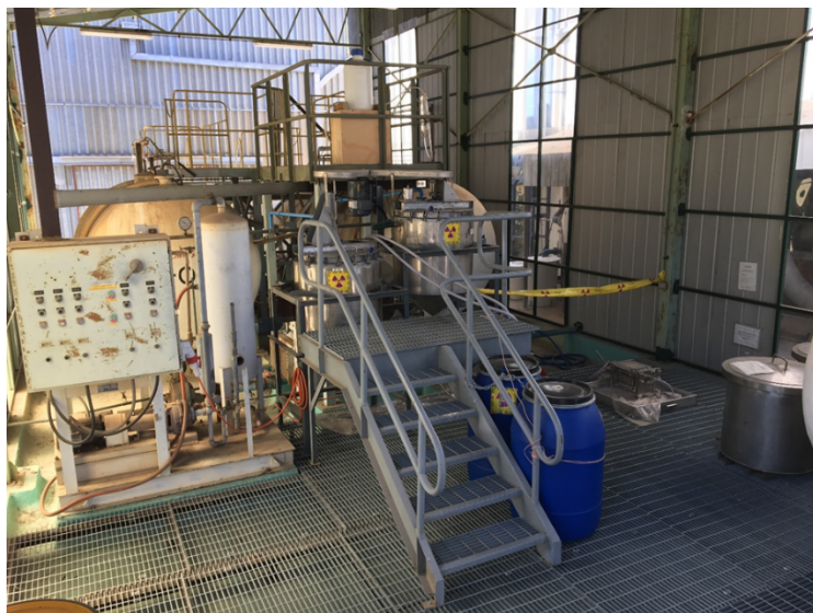
Vista de la Planta de Tratamiento de desechos radiactivos líquidos
