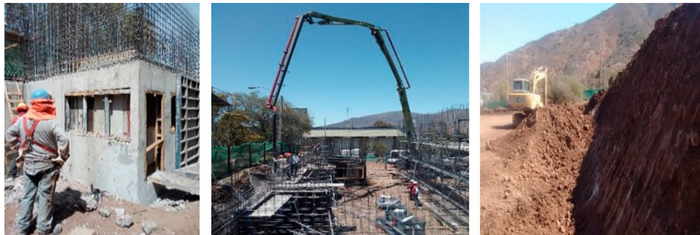
Imagen N° 25: construcción del nuevo almacén de equipos y fuentes gastadas en el CEN Lo Aguirre.
