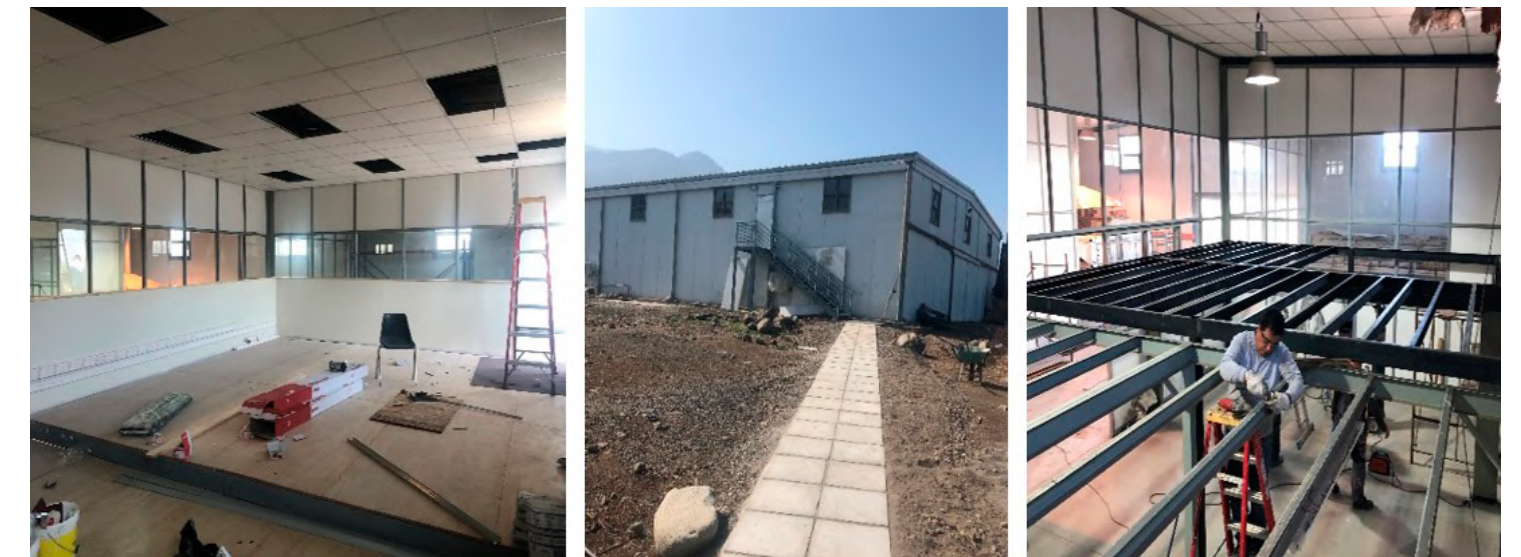
Imagen N° 29: labores de ampliación del Laboratorio de Investigación Nuclear.
