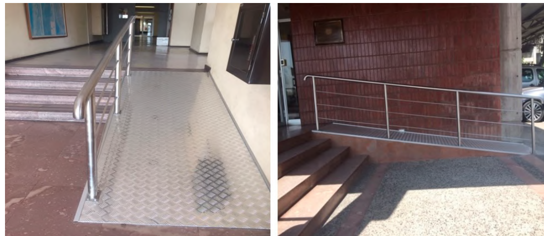
Imagen N° 31: rampas ubicadas en el acceso principal del CEN La Reina.
