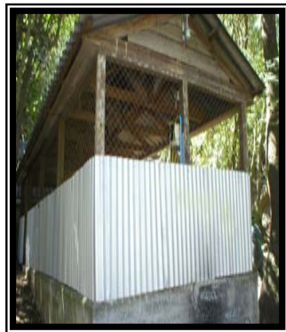
Instalaciones proceso agua potable
