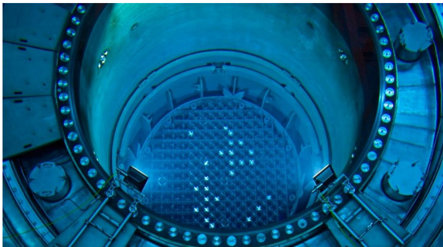
Figura 3-12. Núcleo del reactor.
