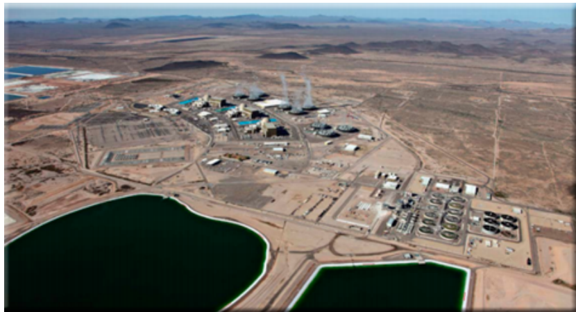
Figura 8: central de energía nuclear Palo Verde. Fuente: Nuclear Energy Institute (2018).
