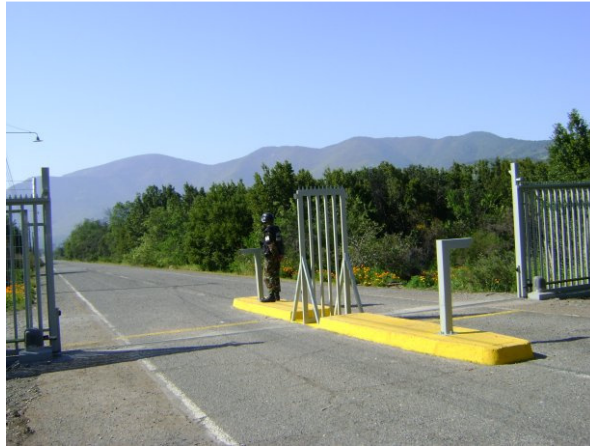
Acceso Principal Cerco Perimetral área nuclear Lo Aguirre
